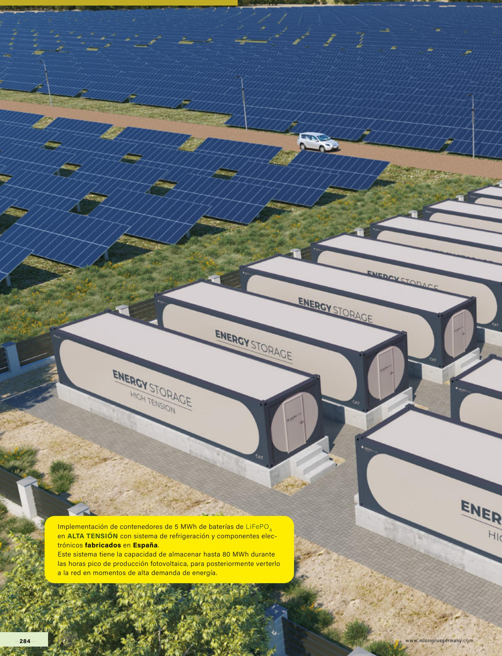
Implementación de contenedores de 5 MWh de baterías de  $\text{LiFePO}_4$  en **ALTA TENSIÓN** con sistema de refrigeración y componentes electrónicos **fabricados en España**.
